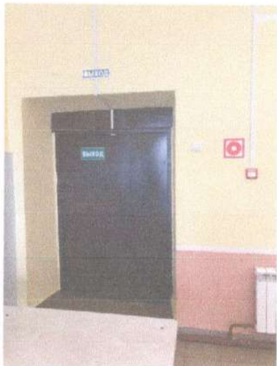
эвакуационный выход 1 этаж
