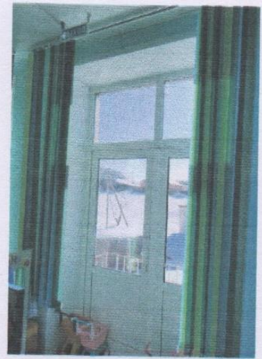
12. Эвакуационный выход с группы 2 этаж
