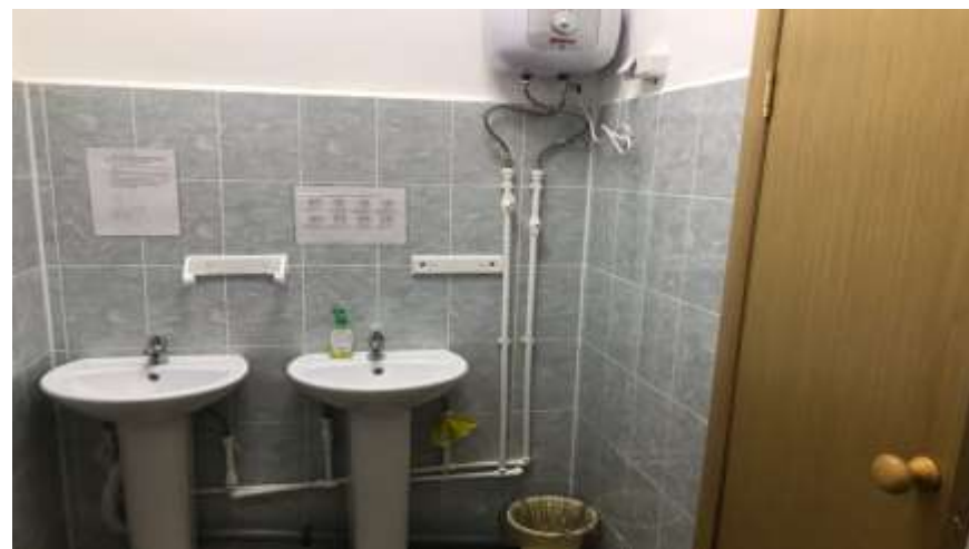
Туалетная комната (1 этаж) №8
