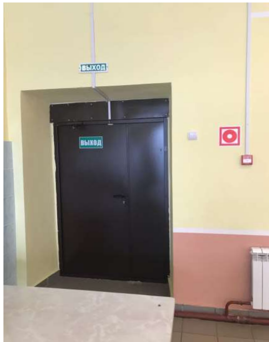
Путь эвакуации(входная дверь внутри здания) №26а
