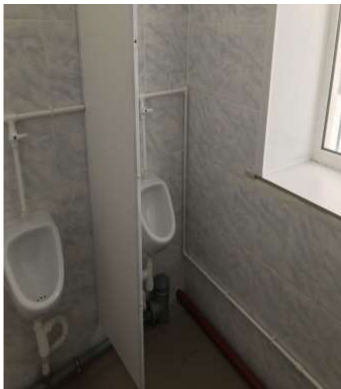
Туалетная комната (2 этаж) №9
