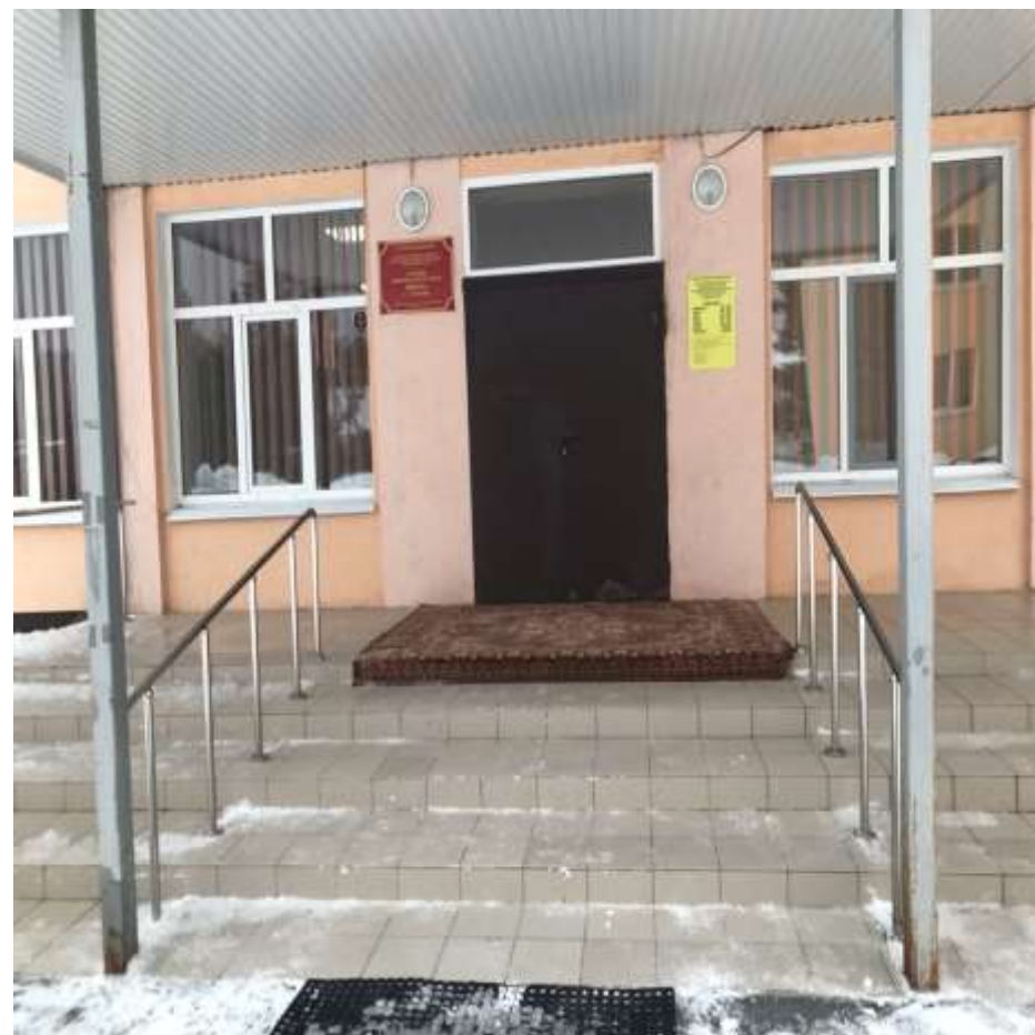
Входная площадка перед дверью №6, лестница №3
