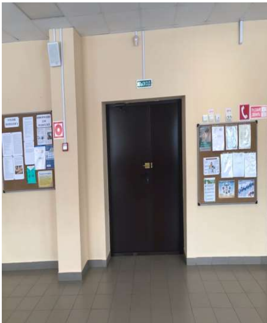
Путь эвакуации(входная дверь внутри здания) №19а
