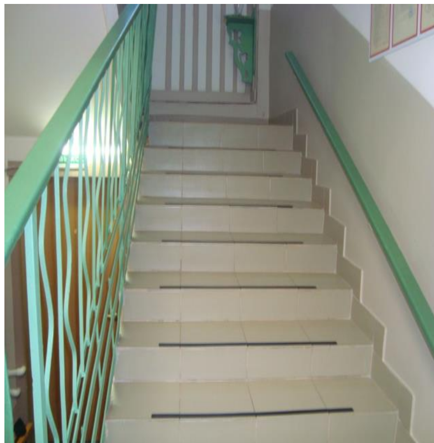
№ 6. Лестница (внутри здания)
